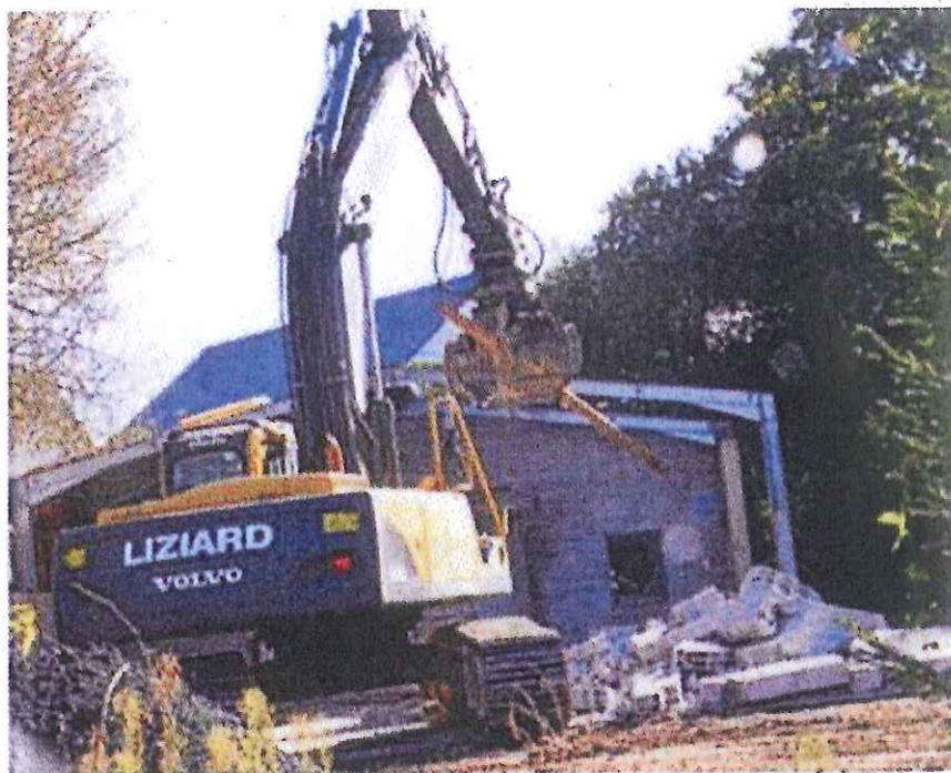
Une pelle mécanique a commencé, hier, à détruire l'ancien hangar du jardinier.
